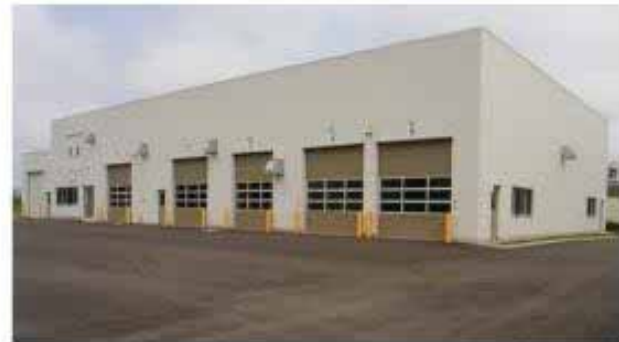
バイオマス混合調整棟外観
