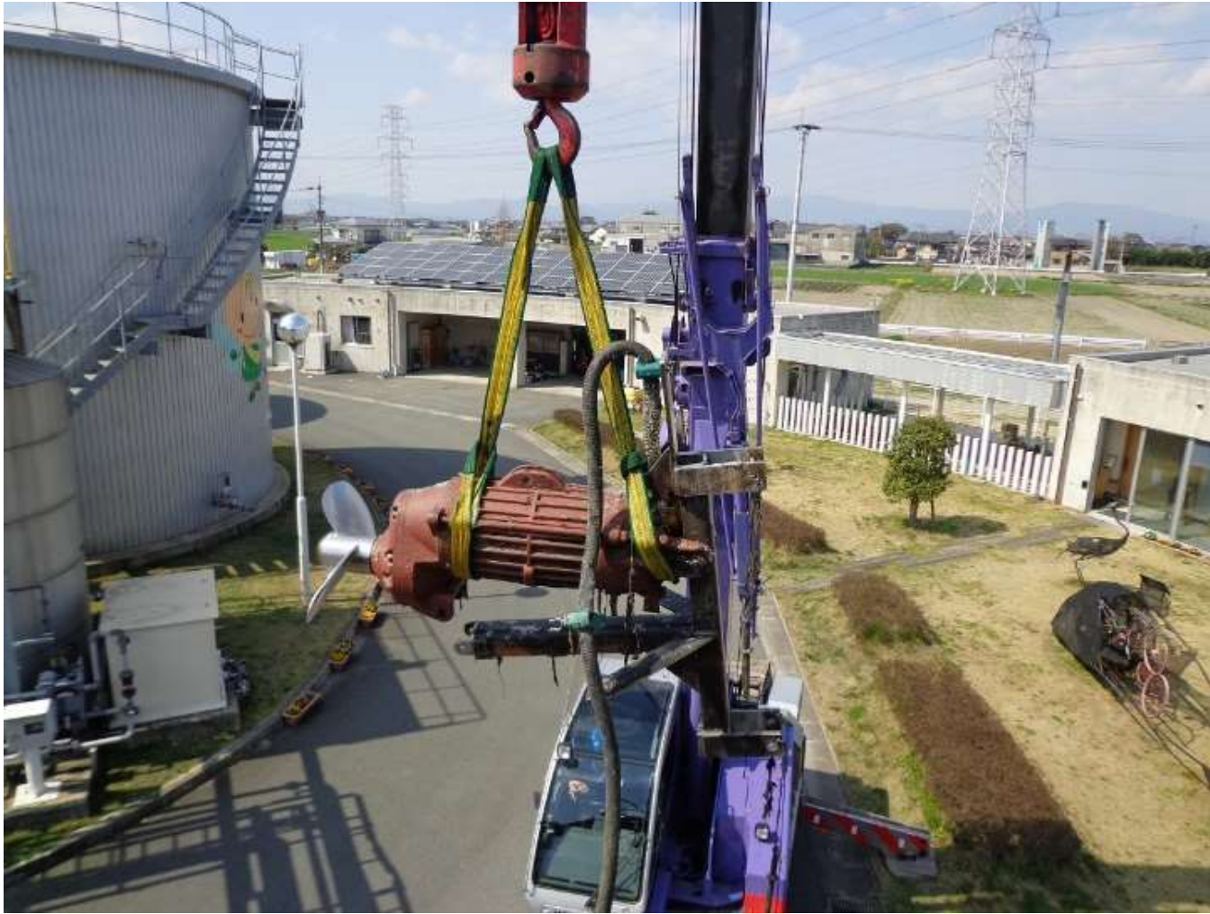
液肥貯留槽攪拌機点検状況
